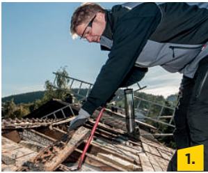
1. Demontage der alten Dacheindeckung und Lattung.
