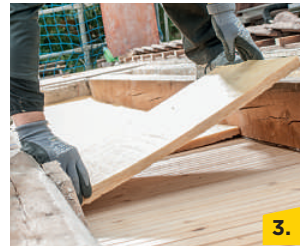
3. Verlegung der Integra UMP-032 Universal-Montageplatten optional als Nagelschutz für die Klimamembran oder zum Höhenausgleich.
