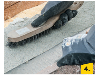
4. Klebestellen mit einer Stahlbürste säubern und von Staub befreien.
