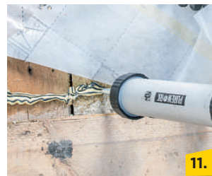
11. Auftragen der Dichtmasse Vario® DoubleFit oder Vario® XtraFit für den Anschluss der Vario® KM Duplex UV an das angrenzende Bauteil.
