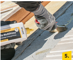
5. Auftragen des Vario® MultiPrime zur Vorbereitung des Untergrunds (Haftvermittler).
