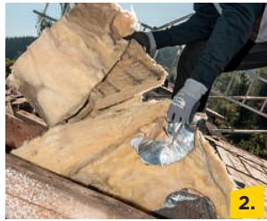
2. Entfernung und fachgerechte Entsorgung der alten Dämmung.
