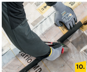
10. Durchgängige Fixierung der Zwischensparren-Sanierungsleisten Vario® ZSL mit einem Handtacker bei offenfugiger Innenbekleidung. Sonst mit max. 30 cm Abstand verlegen.
