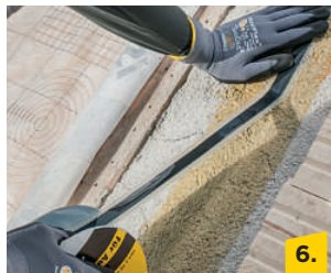
6. Vario® ProTape Xtren auf den mit Vario® MultiPrime vorbehandelten Untergrund auftragen.
