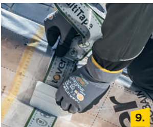
9. Verklebung der Bahnenüberlappungen mit Vario® MultiTape mittig über den Stoß. Aufgedruckte Verarbeitungshilfe auf der Klimamembran erleichtert das Arbeiten.
