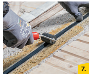
7. Klebekraft des Vario® ProTape Xtren durch Andrücken mit einer Gummirolle verstärken.
