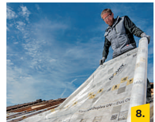
8. Verlegung der Klimamembran Vario® KM Duplex UV bahnenweise und von unten beginnend um die Sparren herum. Bei nachfolgenden Bahnen 10 cm Überlappung vorsehen.
