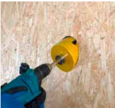
schräge Bohrung
