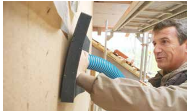
Einblasschlauch in der Anwendung mit Abdichtschwamm
