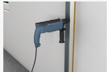
Befestigung der CW-Profile an Massiwand auf Dämmstreifen
