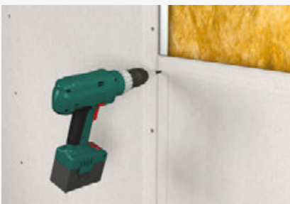
Schrauben auf Stahlunterkonstruktion
