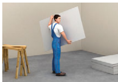
Einzelne fermacell® Gipsfaser-Platten hochkant tragen
