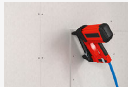
Klammern fermacell® Gipsfaser-Platte auf fermacell® Gipsfaser-Platte (unterkonstruktionsneutral)
