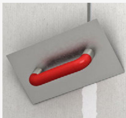
Fugen und Befestigungsmittel verspachteln
