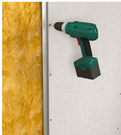
Befestigung mit Schrauben
