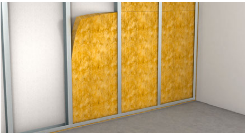
Einbringen der Dämmstoff-Platten
