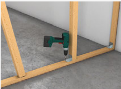
Montage der Holzständer mit Stiftnagel oder Stahlwinkel
