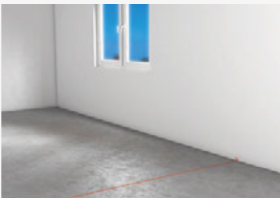
Anlegen der Wandachse mit Schnurschlag oder Hochbaulaser
