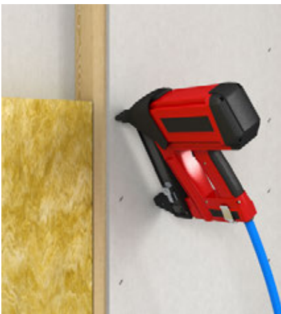
Bekleidung der Holzunterkonstruktion mit Klammern
