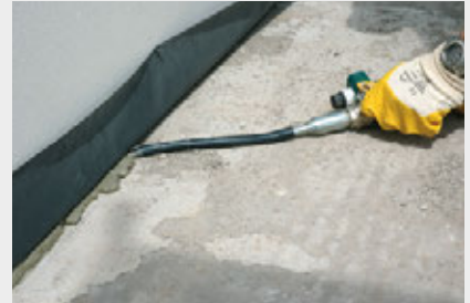
Maschinelles Verfüllen der Bauteilfuge
