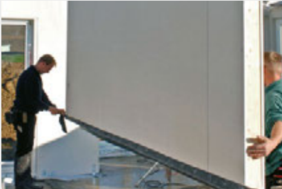
Positionieren, Ausrichten und Unterklotzen der Wandelemente
