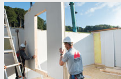
Montage auf der Baustelle
