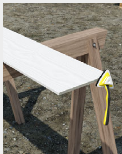
Auftragen der ColourPlus™ Kantenversiegelung vor der Montage.
