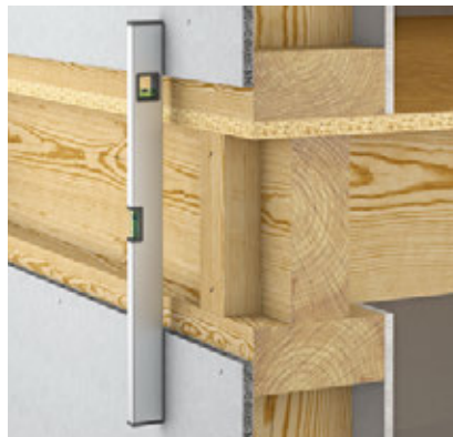
Bild 1: Ausrichten der Wandelemente
