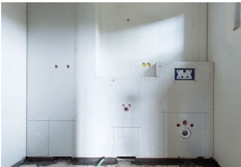
Tragständer für wandhängende WCs mit Einbauspülkästen
