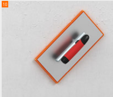
Abfilzen der Putzoberfläche mit einer Schwamm-scheibe
