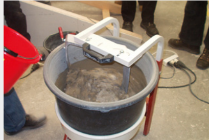
Anmischen fermacell™ Quellmörtel
