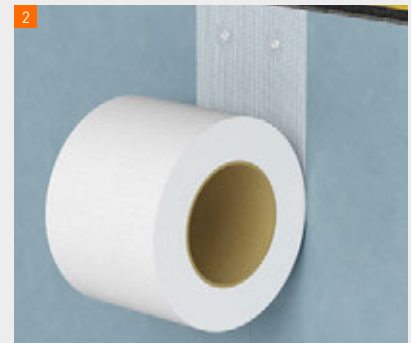
Aufbringen des fermacell™ Armierungsbandes HD
