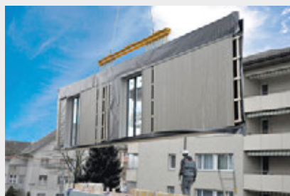
Krantransport auf der Baustelle
