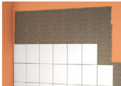
Abb. 8: Verfliesung mit fermacell™ Flexkleber im Dünnbettverfahren auf vollflächiger Abdichtung
