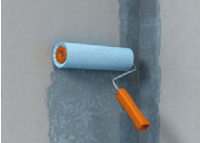
Abb. 1: Vollflächiges Aufbringen des fermacell™ Tiefengrunds – Trocknungszeit mind. 2 Stunden - Mischungsverhältnis: 1:1 bis 1:2 mit Wasser
