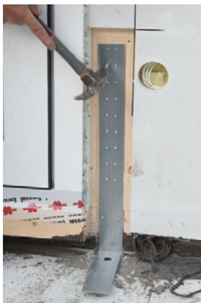
Montage Zuganker (Verdübelung Lastplatte noch nicht erfolgt)
