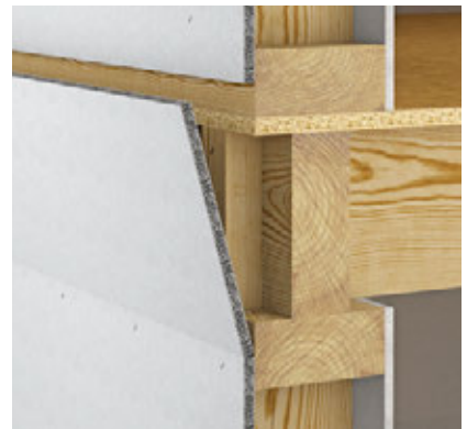
Bild 2: Montage des Plattenstreifens
