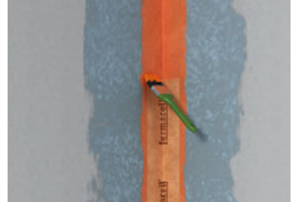
Abb. 2+3: fermacell™ Dichtband in die zuvor aufgetragene, noch feuchte fermacell™ Flüssigfolie drücken und direkt mit Flüssigfolie überstreichen – Trocknungszeit mind. 1 Stunde
