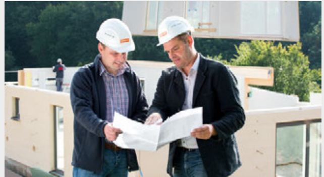
Kompetente Beratung durch Holzbau-Spezialisten der Fermacell GmbH
