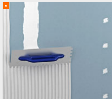
Aufbringen des fermacell™ Leichtmörtels HD mit 5–6 mm Schichtdicke für den Grundputz
