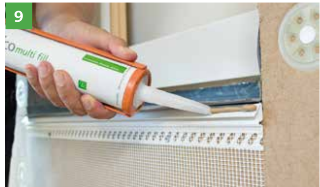
9 Die vorstehende Lasche der aufkaschierten Unterspannbahn wird mittels STEICOmulti fill mit der Tropfkante des Attikaprofiles verklebt.
