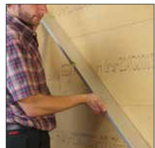
Kontrolle der Oberfläche
