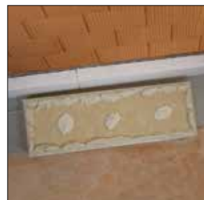
Dämmplatte ankleben auf unebenem Untergrund im Punkt-Wulst-Verfahren
