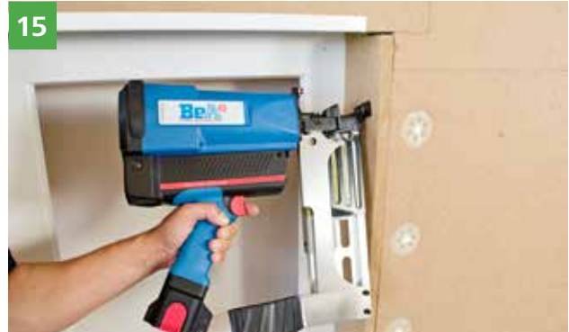
15 Fixierung der Laibungsplatte als Pressdruck zur ungestörten Aushärtung von STEICOmulti fill mittels Breitrückenklammern oder Edelstahlschrauben.
