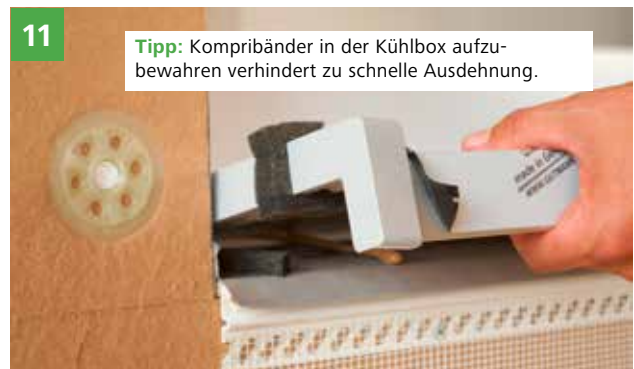
11 Einbau Fensterbank. TIPP: Die hintere Blechverfaltung befindet sich in der passenden Fensterrille, die vordere hat einen Abstand von \geq 3 cm zur Putzfassade.
