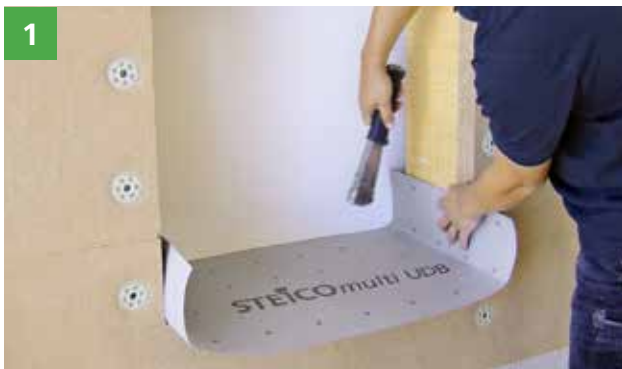
1 Anbringen von STEICO multi UDB (diffusionsoffene Unterdeckbahn) als temporärer Witterungsschutz bis zum Einbau.
