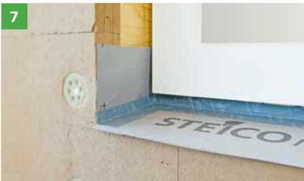
7 Einsetzen des STEICOfix Dämmkeils in die Laibung, restliches Abziehen des Klebeband-Liners und Andrücken des STEICOmulti tape F Klebebands.
