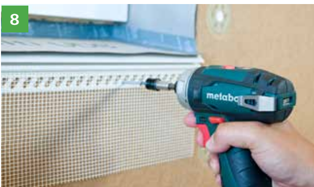
8 Für den sicheren Putzanschluß wird unterhalb des STEICOfix Holzfaser-Dämmkeils ein Attikaprofil installiert (Edelstahl-Schrauben oder -Klammern in die Holzfaser-Dämmplatte).
