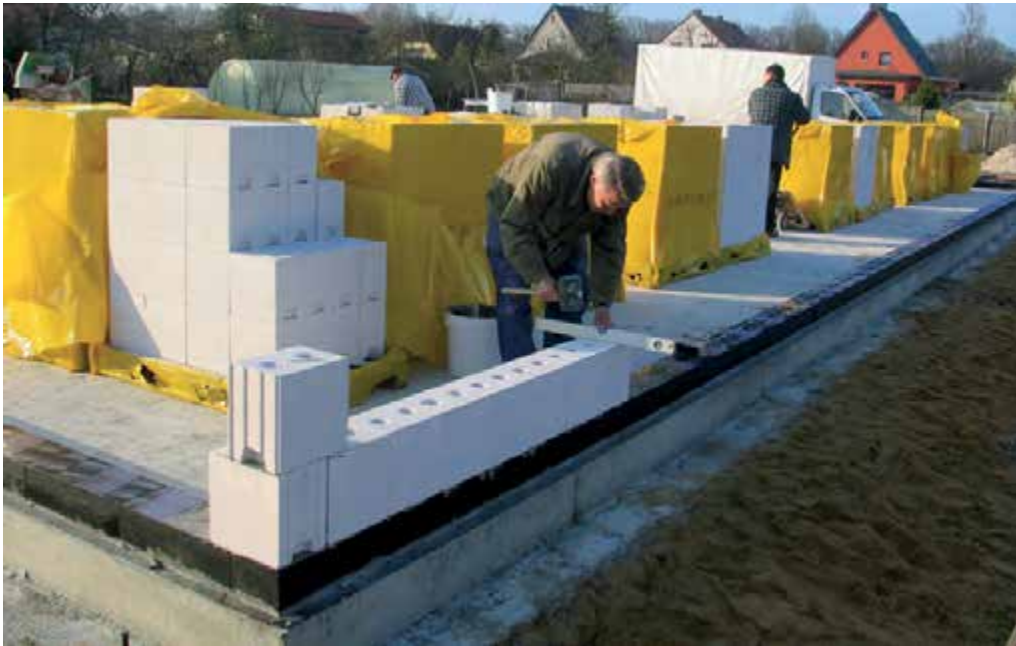
Mauerfußdämmung mit FOAMGLAS® PERINSUL unter Kalksandsteinen.
