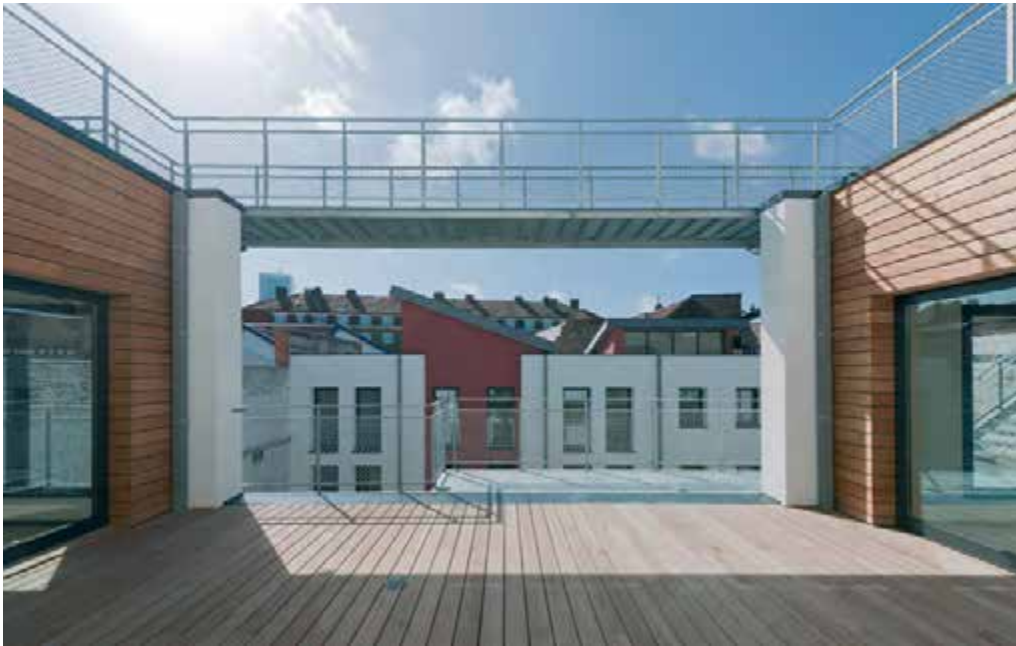
Wohnbebauung, LD2 Architecten, Brüssel. Foto Marc Detiffe
