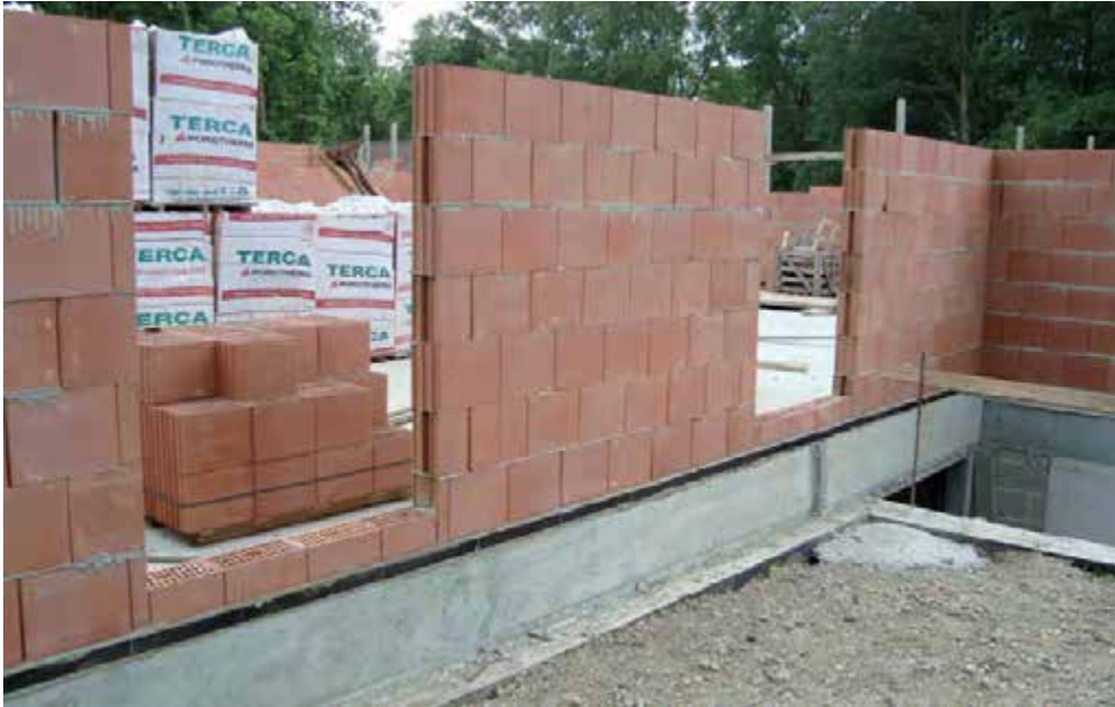
Mauerfußdämmung mit FOAMGLAS® PERINSUL unter Hochlochziegeln.
