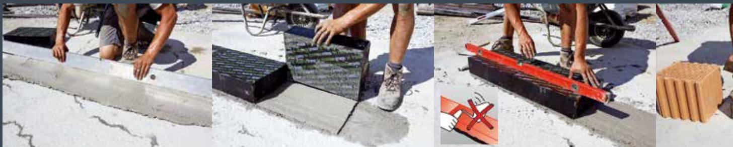
Verteilen des fließfähigen Mörtels.
