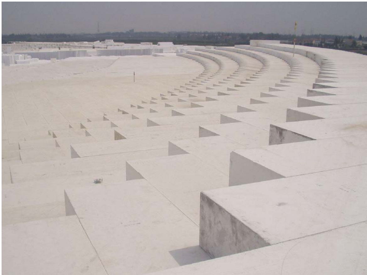
Foto: Tribnen der Formel-1-Strecke von Shanghai im Bauzustand
