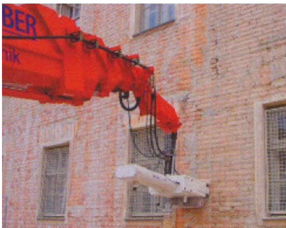
Foto: Fassadenfräse im Einsatz
