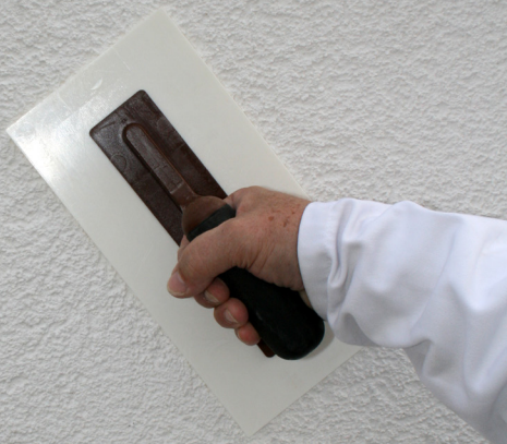
Unter- und Oberputz
